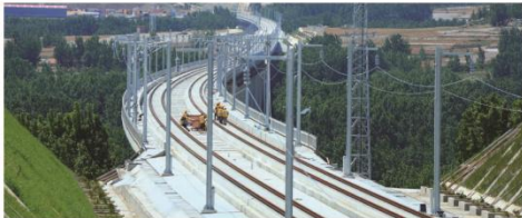
◆ 隧道、路基、桥下等绿化恢复
