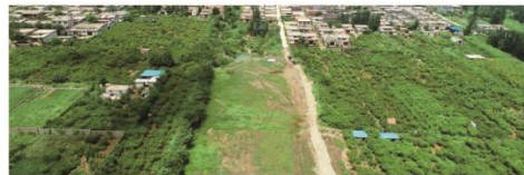
◆ 已竣工土壤平整的噪声矿坑
