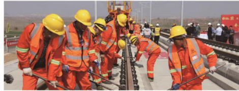
★ 莱荣高铁铺轨
