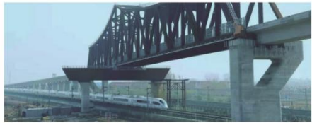
★高速铁路钢桁架梁技术成功应用
