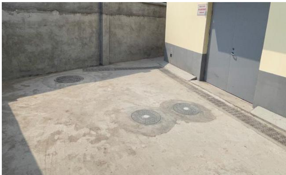
黄台站化粪池
